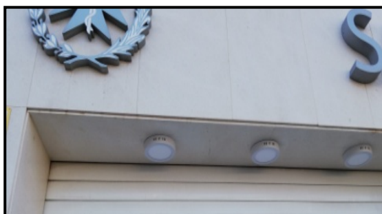
Imagen 8: Nuevos focos puerta salón
